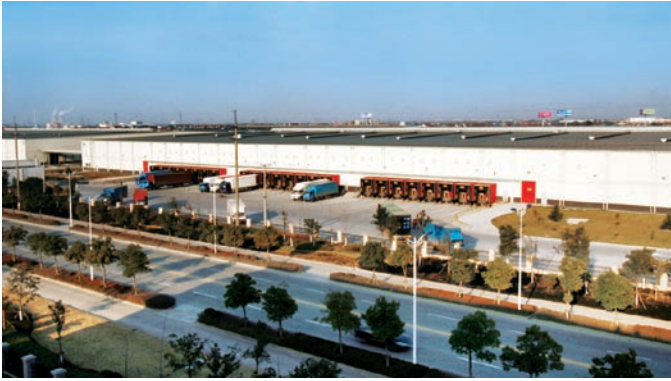
AMB facility in Fengxian district, China
